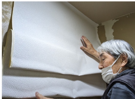
壁紙の張り替え作業！職人技が冴えます。
